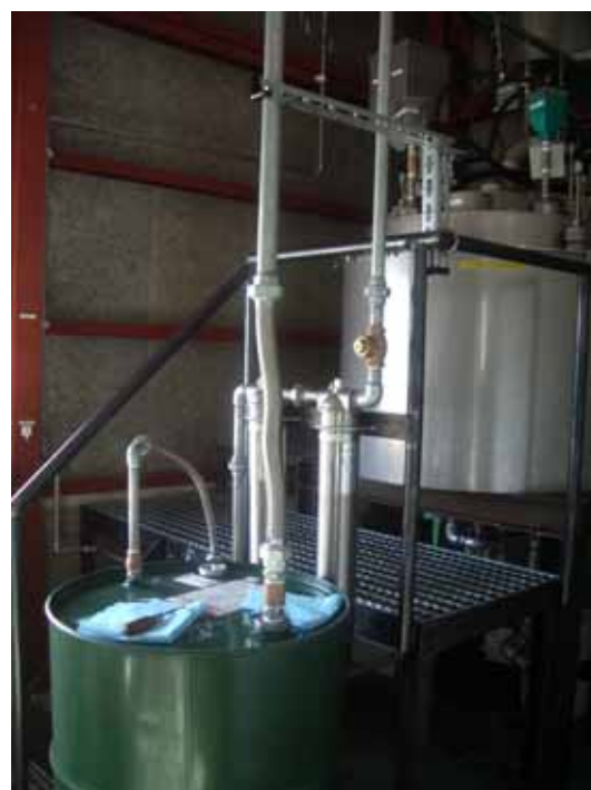
使用済み油のBDF化プラント（2008.4.6 撮影）
