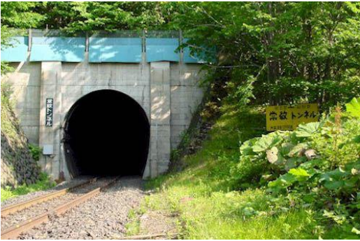
図 12-3 常紋トンネル
