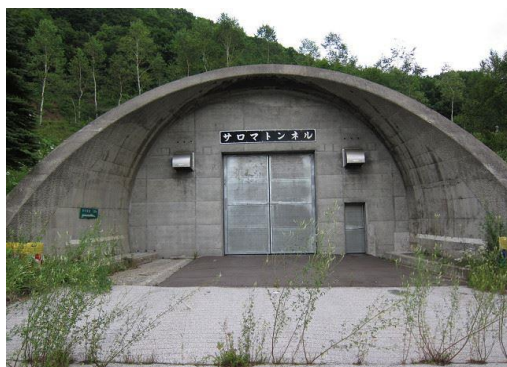
図 12-6 旧佐呂間トンネル
