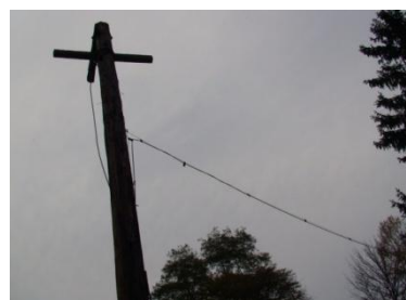
写真 2-4 官舎跡近くの電柱
